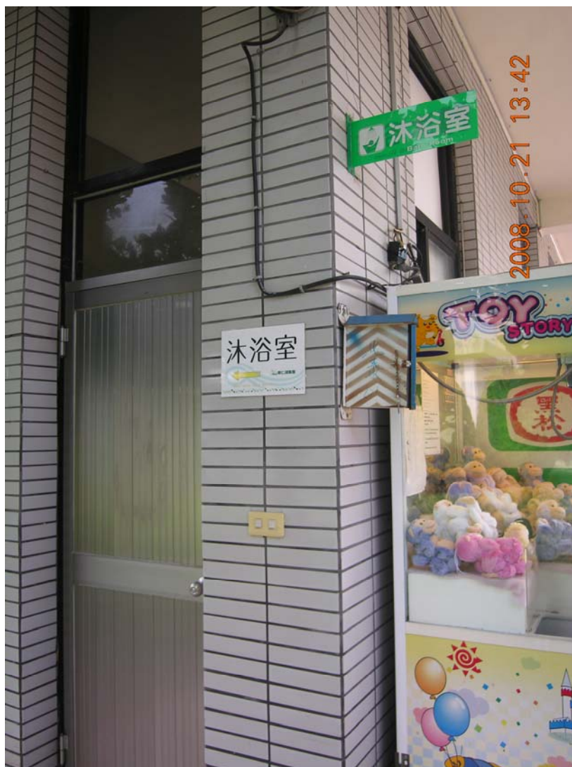
照片七：泰安服務區提供之沐浴室
